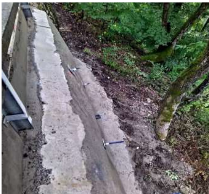
Spritzbetonwand mit Felsanker August 2022
